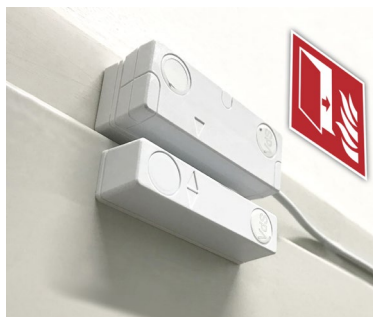
Montage des neuen Blockkontaktes an einer Sicherheitstür
